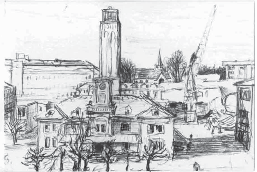
Abb. 13 Verwaltungsgebäude, Spitalküche und Chirurgie vor dem Abbruch, Zeichnung von Viktor Surbek
