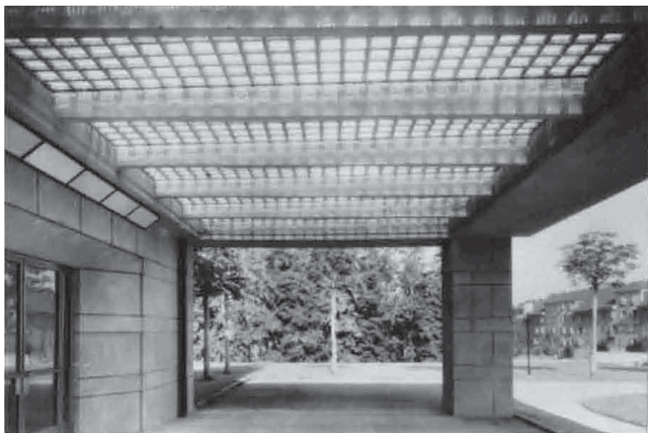
Abb. 37 Lory, unter dem Vordach des Haupteinganges
