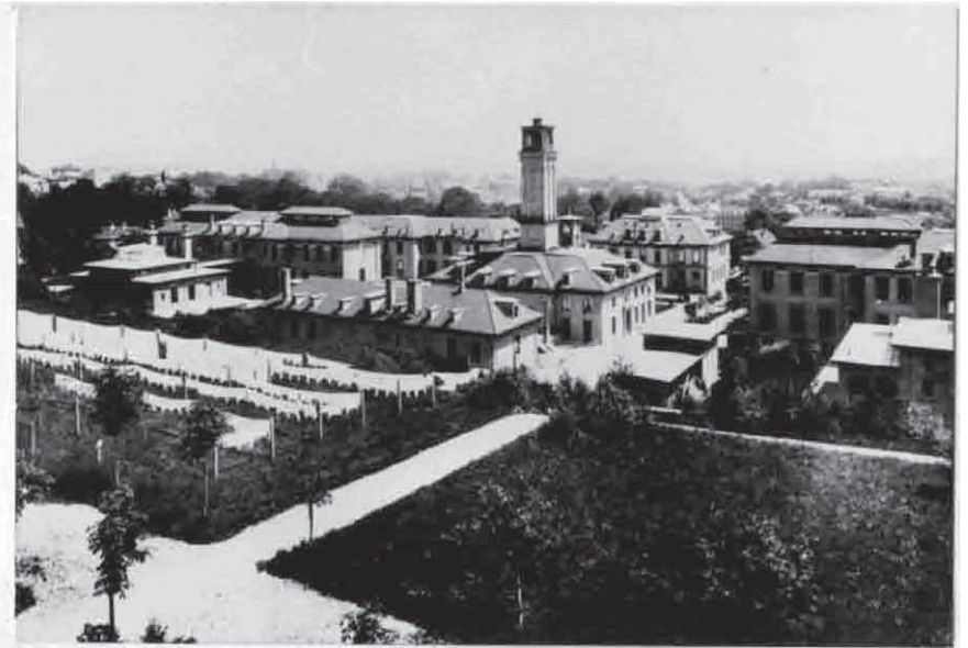
Abb. 12 Die Spitalbauten, Ansicht von Westen
