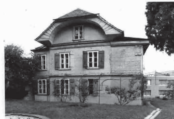
Abb. 17 Rosenbühl, Foto unmittelbar vor dem Abbruch
