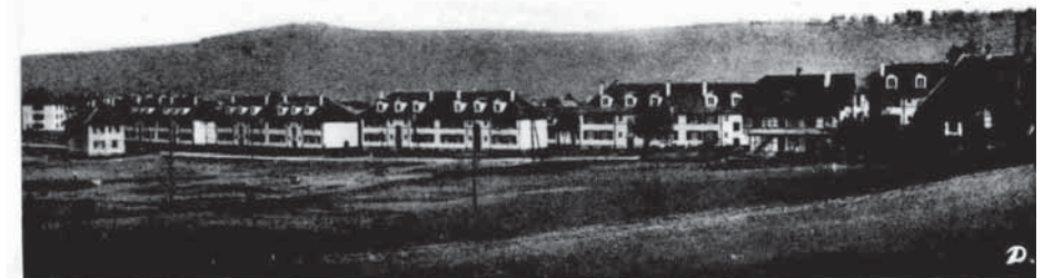
Abb.10 Brünmattquartier von SW und NW
