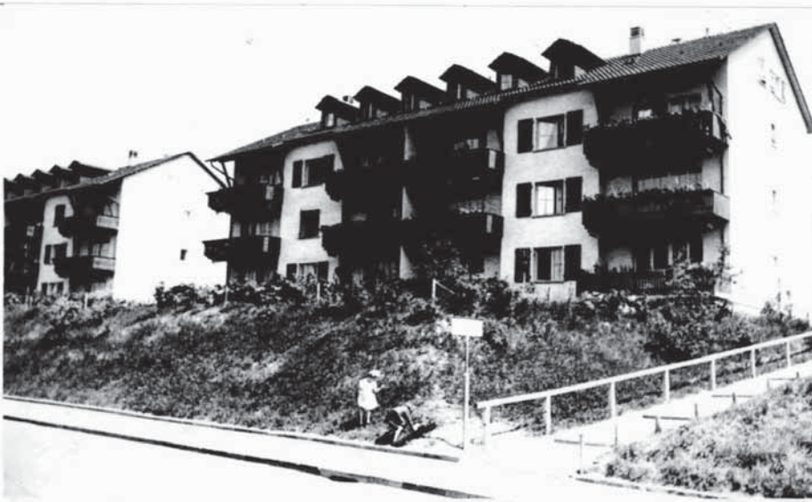
33 'Neuere Quartierbebauung' Bethlehemstrasse 157/159
